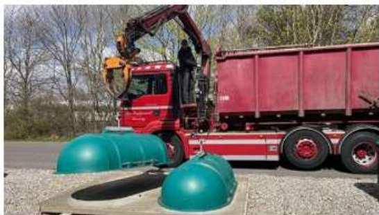
En god afhentningsplads har fast underlag og intakt kappe. Foto: DAKA
